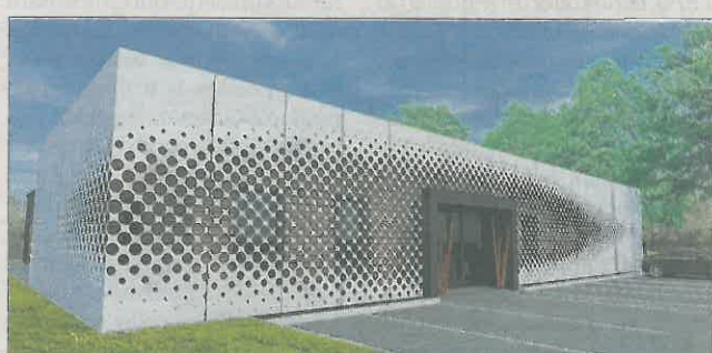
Un look soigné pour un bâtiment de 600 m 2 qui sera livré en juillet 2018.
